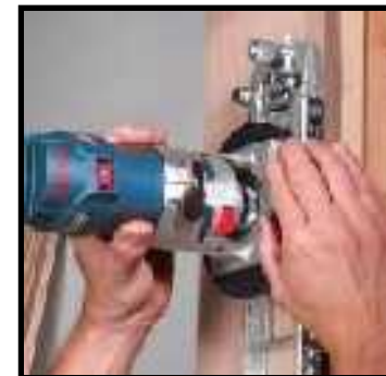
Frezare orificiu pt. balamale
